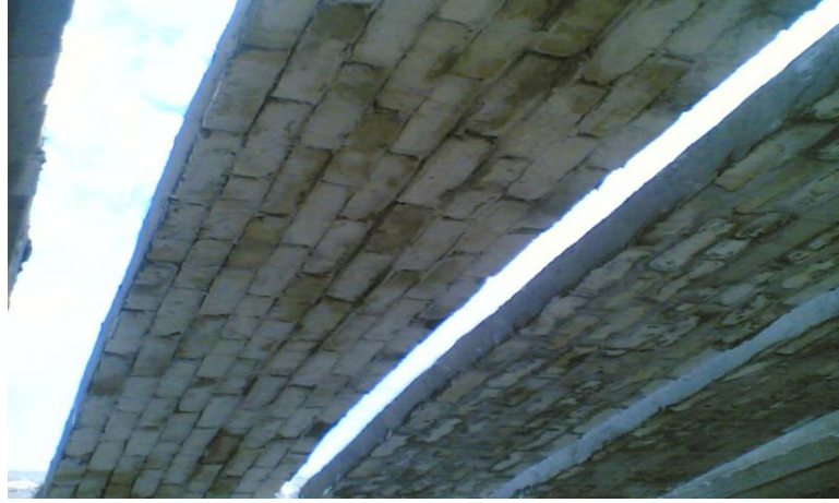
شكل رقم (7) يوضح تحمل القوس للأحمال التصميمية المسلطة
